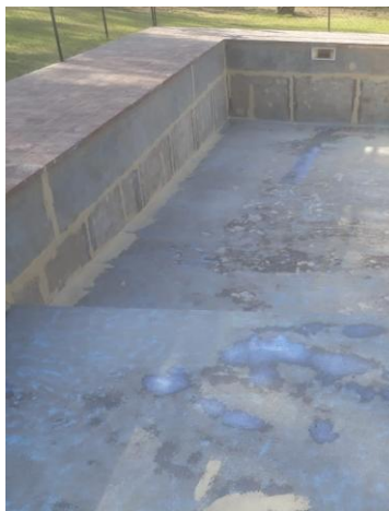
IMPRIMACION, pileta arenada y reparada
