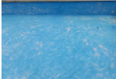
Pintura desbastada con disco diamantado
